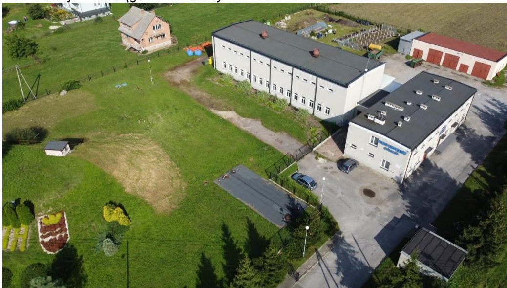
Fotografia 14 Stacja wodociągów w Drzewicy
