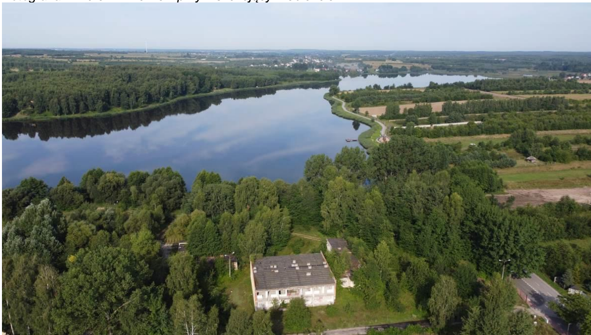
Fotografia 7. Zalew Drzewicki przy niszczącym obiekcie
