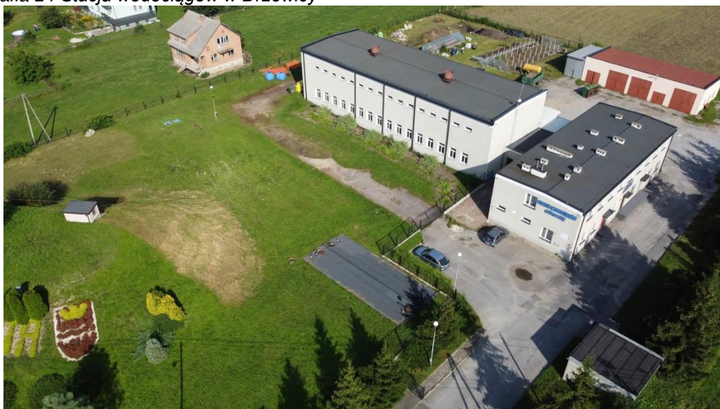
Fotografia 14 Stacja wodociągów w Drzewicy
